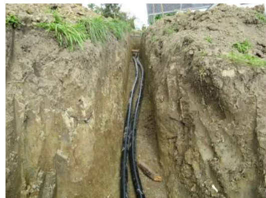
L'eau chaude s'écoule par des conduites à distance vers le consommateur
